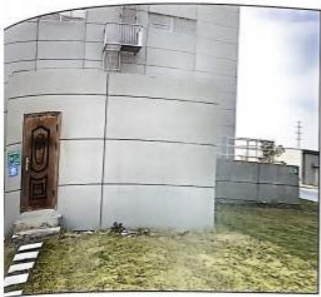
污水处理站在线监测站房
