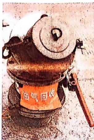
图3 油气回收装置
