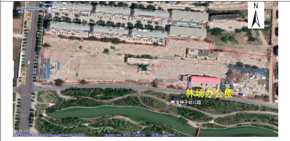
2020年5月历史卫星影像图： 居民住宅、停车场已拆除。
